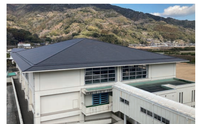
生比奈小学校体育館
