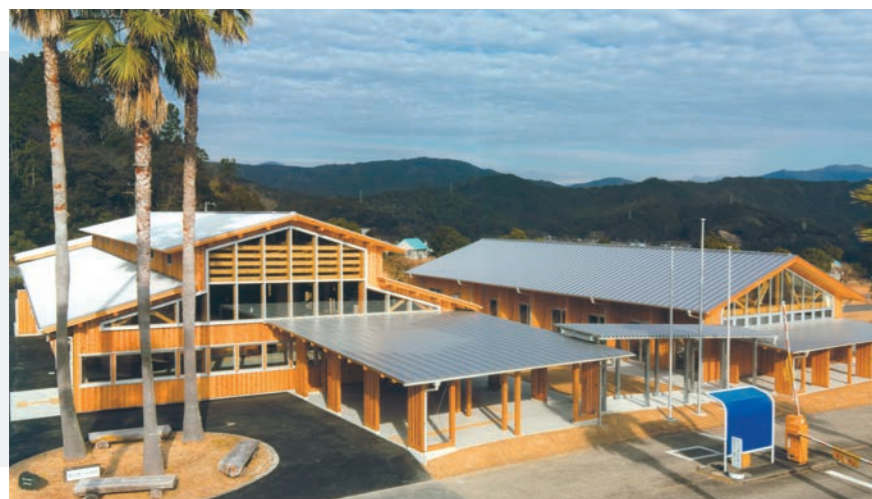
まぜのおか 管理棟・交流棟
